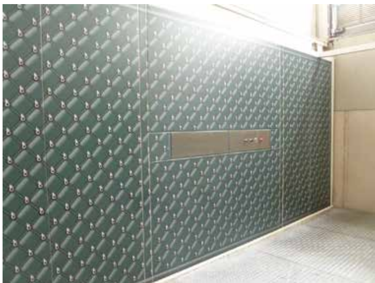
Liftschacht hotel voorzien incl. uitsparingen bedieningspaneel
